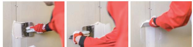
Avant de recouvrir le produit d'une peinture, utilisez un enduit de finition sur l'ensemble de la surface approprié pour obtenir une surface parfaitement homogène.
