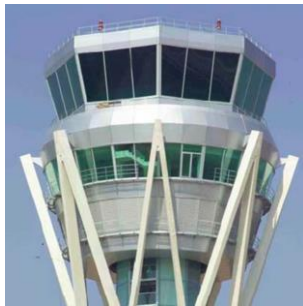
Torre control Aeropuerto Barcelona (España) 2005
