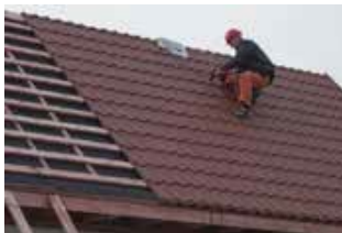
União e selagem de coberturas multimateriais
