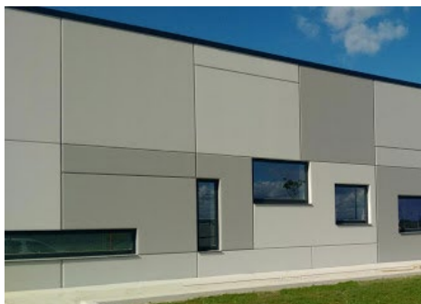
Juntas verticales entre prefabricados de hormigón
