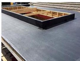
Unión de membranas EPDM, tanto vertical como horizontalmente, sobre sí mismas y sobre los soportes más habituales utilizados en la construcción: hormigón, cemento, ladrillos, albañilería, tejas, metales, madera, y muchos plásticos como PVC, PC, PMMA, ABS, ...
