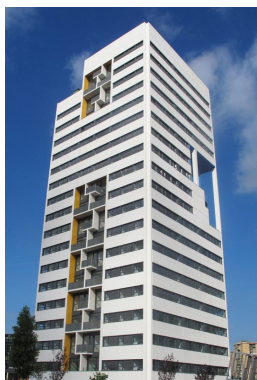
100-Edifício de habitação Barcelona (Espanha)
