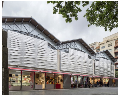
Remodelação do mercado "El ninot" Barcelona (Espanha)
